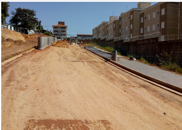
Vista construção de calçadas
