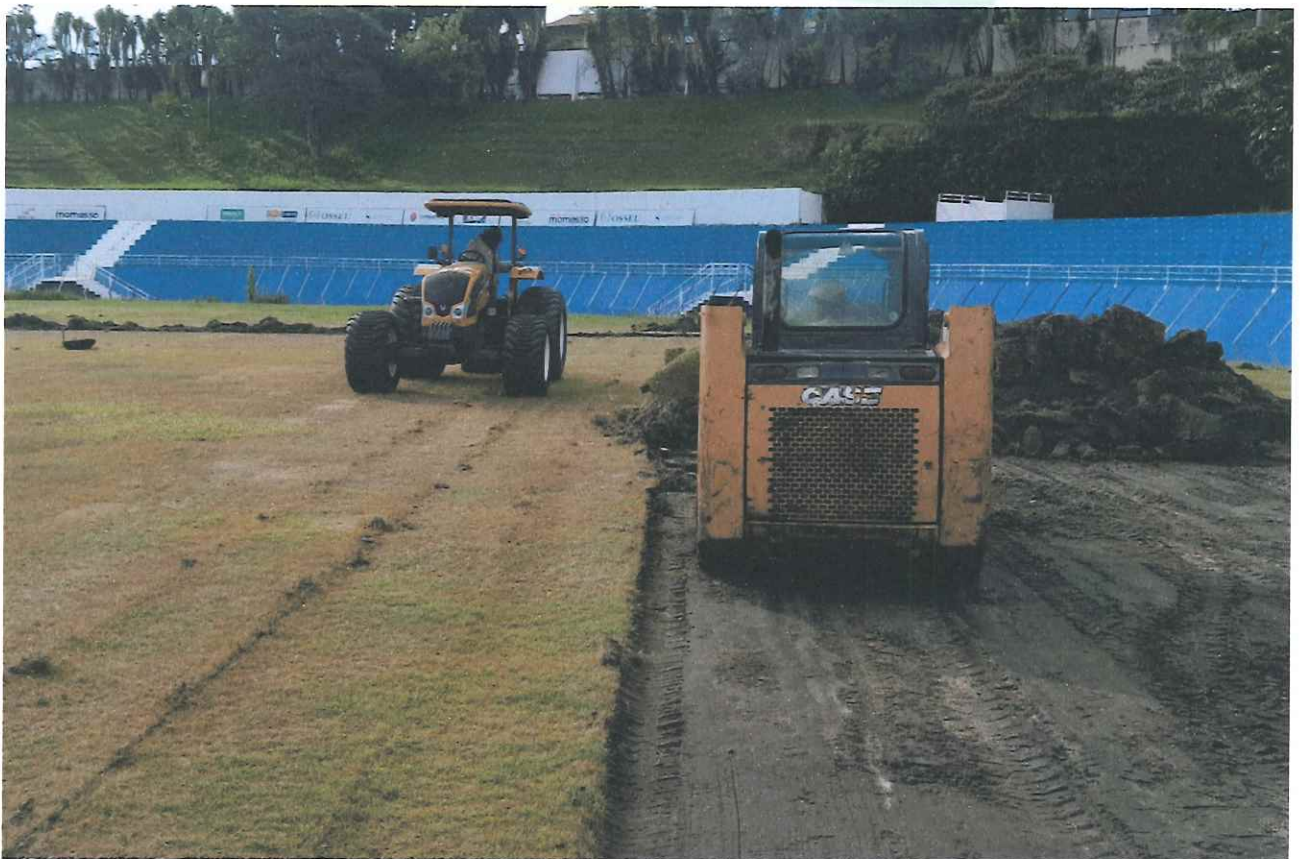
Figura 3 - Escavação mecanizada com transporte do material removido.
