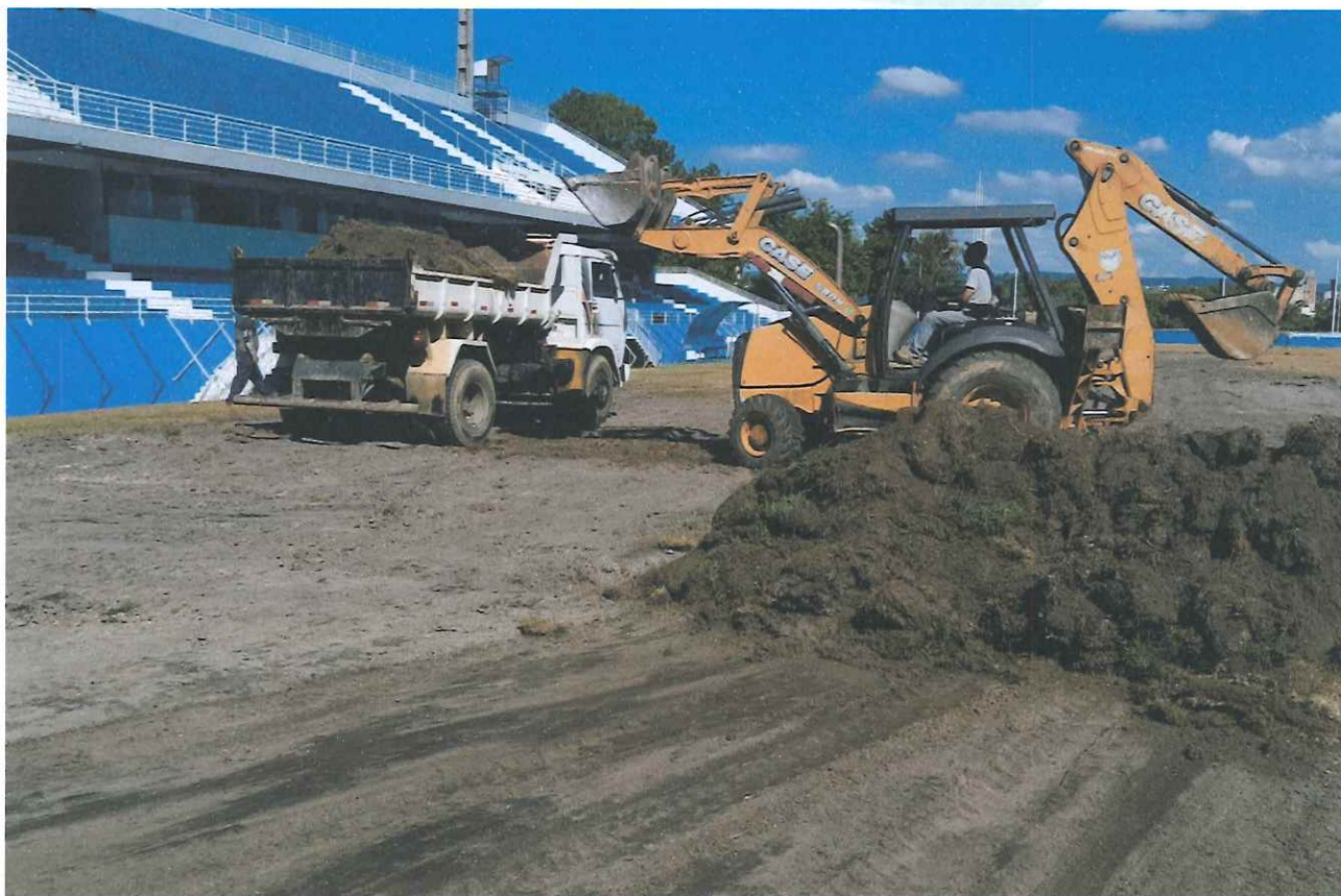
Figura 5 - Escavação mecanizada com transporte do material removido.
