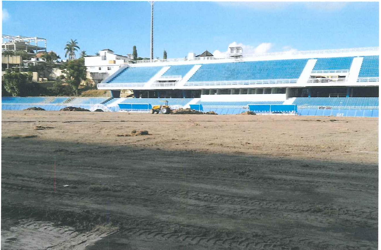
Figura 6 - Escavação mecanizada com transporte do material removido.
