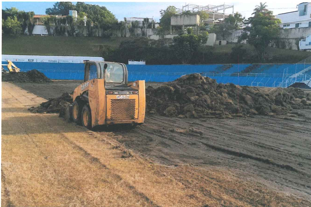
Figura 4 - Escavação mecanizada com transporte do material removido.
