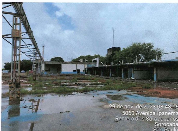
DEMOLIÇÃO ALVENARIA E ESTRUTURA METÁLICA
