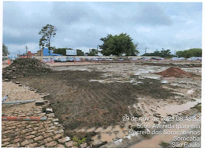
RETIRADA DE PARALELEPIPEDO
