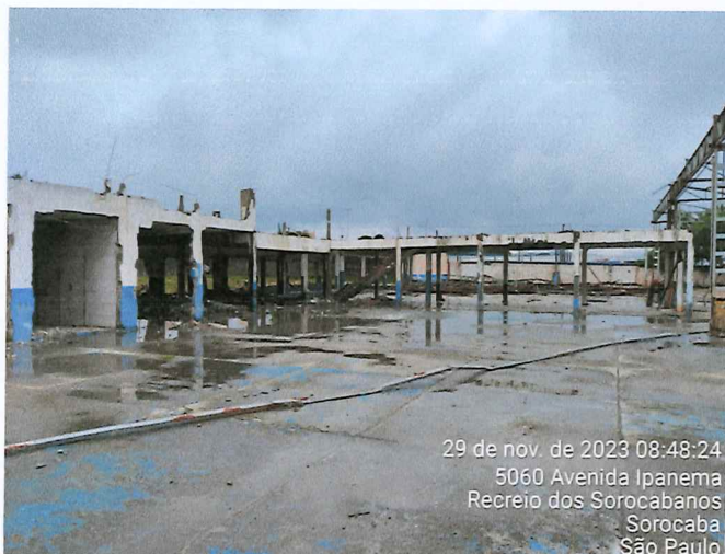
DEMOLIÇÃO ALVENARIA E ESTRUTURA METÁLICA
