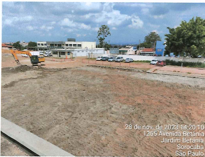
RETIRADA DE PARALELEPIPEDO
