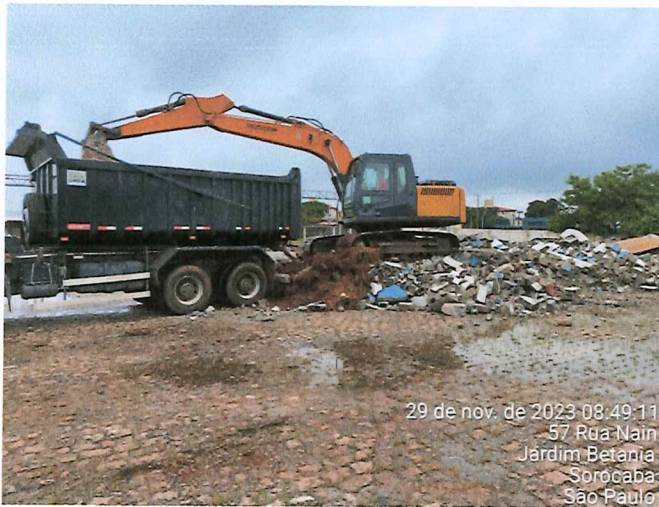
CARREGAMENTO DE ENTULHO
