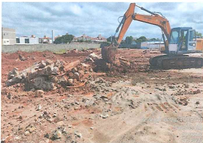
REMOÇÃO E TRANPORTE DE ENTULHO
