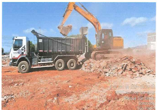
REMOÇÃO E TRANPORTE DE ENTULHO
