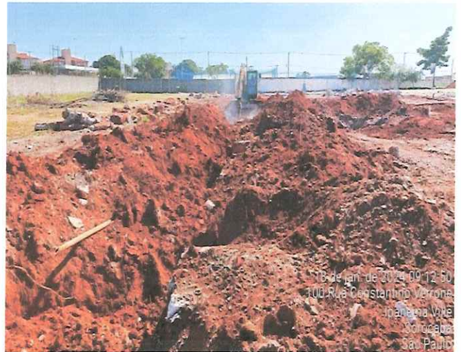
REMOÇÃO E TRANPORTE DE ENTULHO
