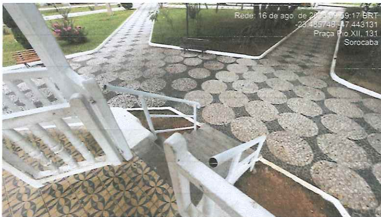
Foto 1 – Tamponamento dos tubos de aço dos corrimãos
