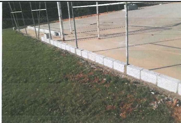
Retirada de Alambrado geral da quadra
