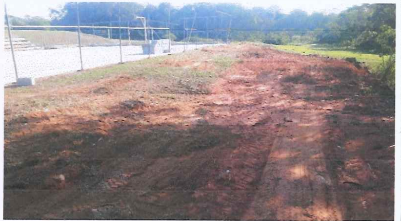
Remoção de troncos de árvores
