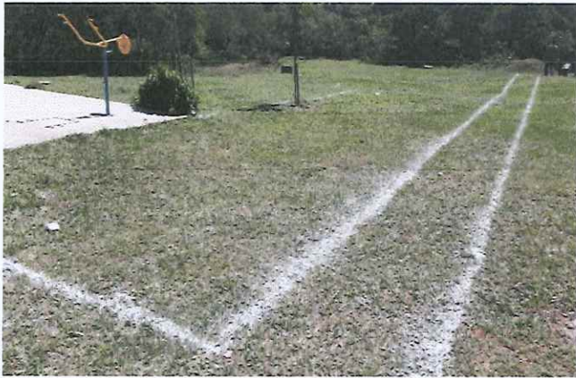
Locação de vias e calçadas
