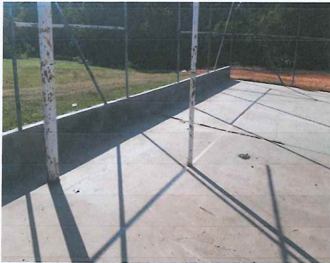
Mureta quadra poliesportiva rebocada
