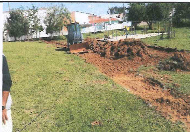
Escavação mecanizada playground e passeio
