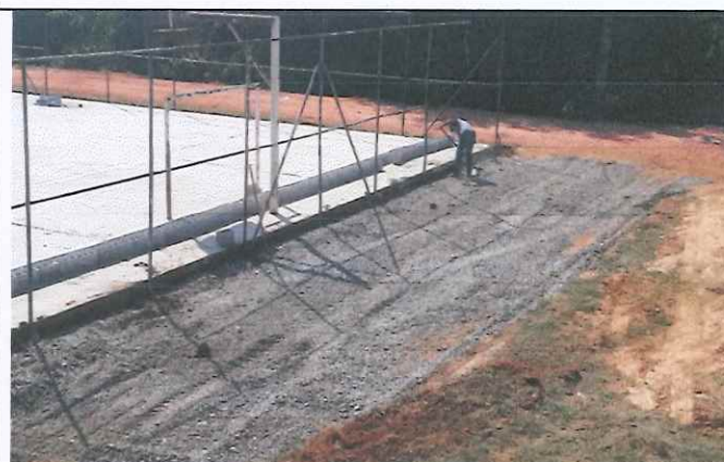
Terraplanagem no estacionamento piso Intertravado
