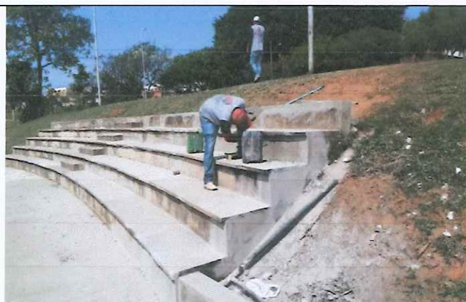
Apicoamento de piso/parede arquivancada
