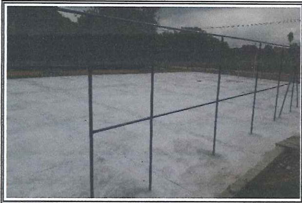
Execução de piso de concreto da quadra
