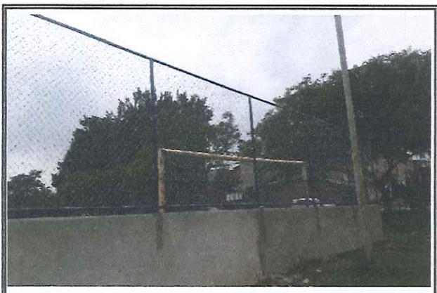
Instalação de alambrado Campo
