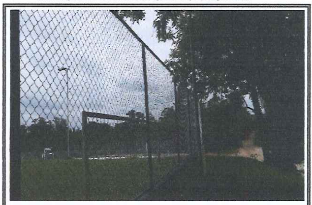
Instalação de alambrado Campo
