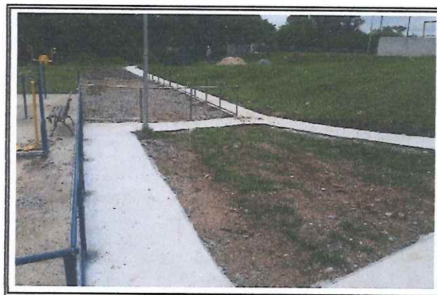
Execução de Calçada (passeio)
