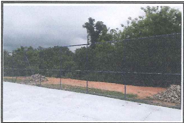
Instalação de alambrado quadra poliesportiva
