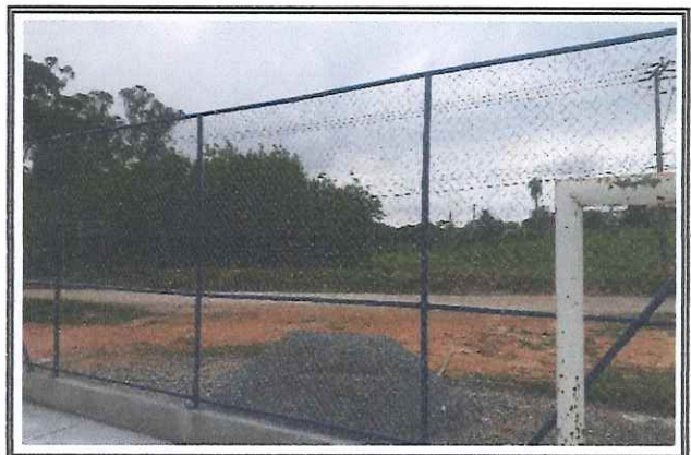
Instalação de alambrado quadra poliesportiva
