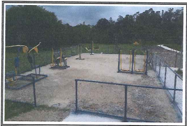
Instalação de alambrado academia ar livre
