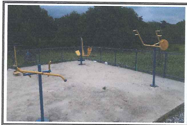
Instalação de alambrado academia ar livre
