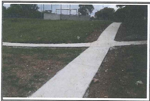
Execução de Calçada (passeio)
