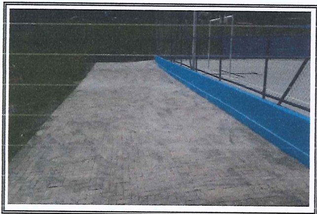
Execução de piso intertravado pátio da quadra
