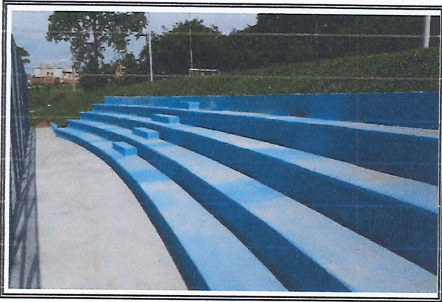
Pintura da arquibancada da quadra
