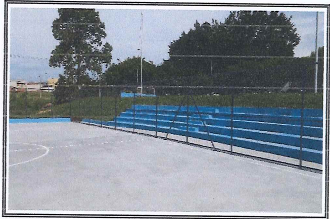
Pintura da arquibancada da quadra
