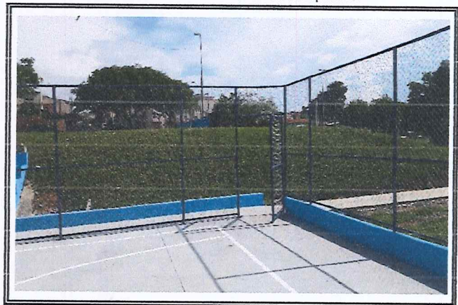
Pintura das linhas demarcatórias da quadra
