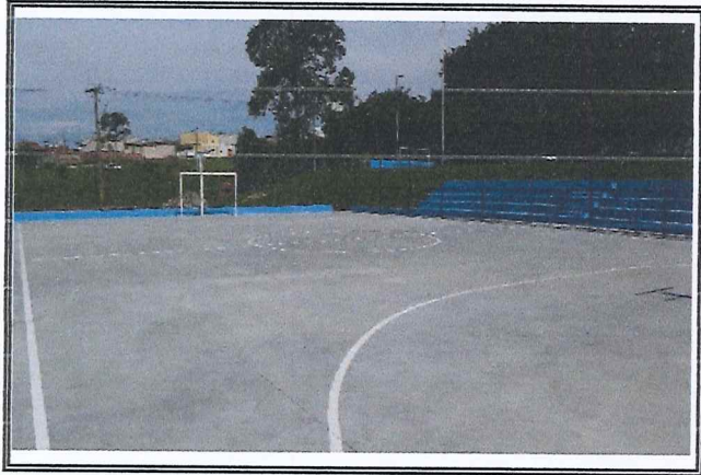
Pintura das linhas demarcatórias da quadra
