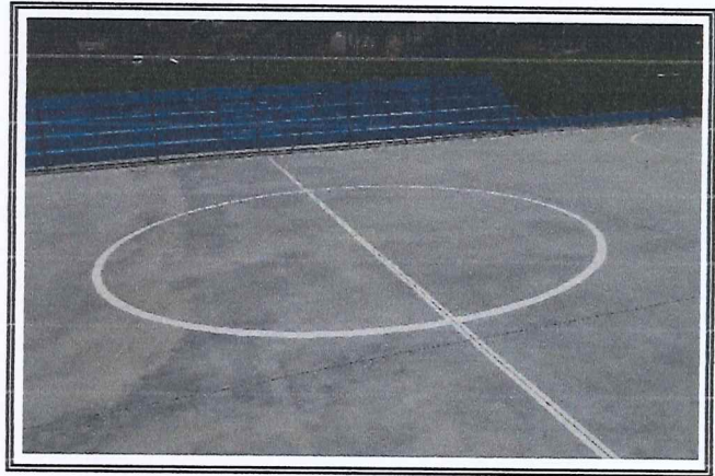
Pintura das linhas demarcatórias da quadra
