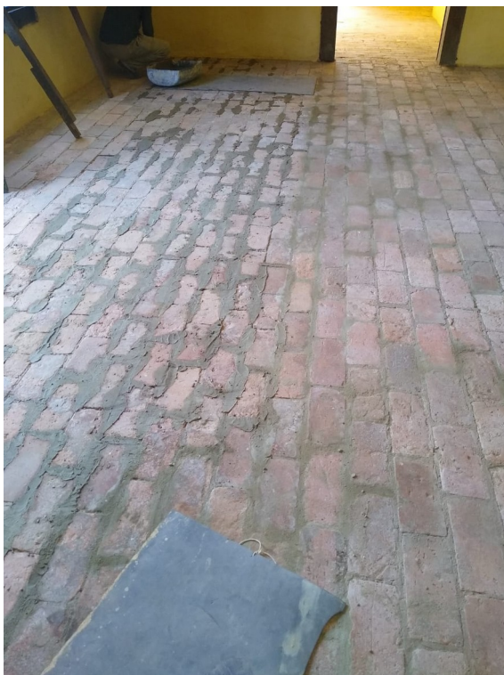
Foto 112: Troca dos tijolos deteriorados e rejuntamento ;
