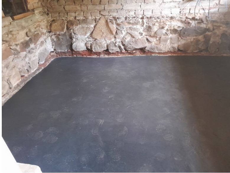
Foto 98: Concretagem e aplicação de pintura no piso do porão:
