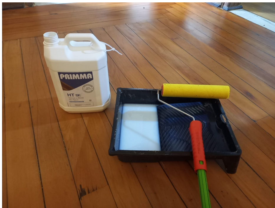
Foto 87 : Aplicação de cera Primma no assoalho de madeira;
