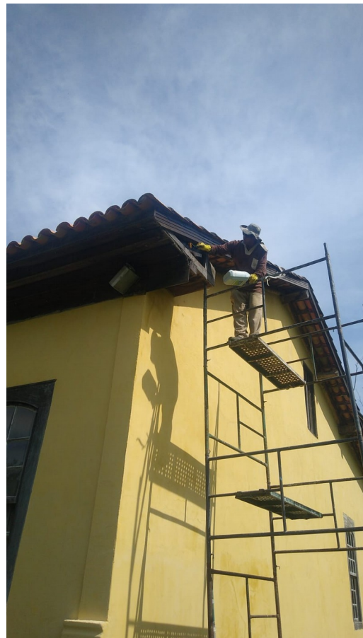
Foto 110: Restauro e pintura com stain nos beirais externos;
