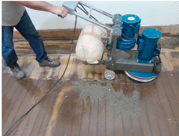
Foto 86: Raspagem e calafetação do piso interno de madeira:
