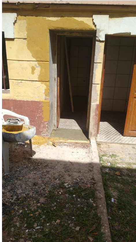
Foto 92: Requadramento da fachada e piso na abertura do vão;
