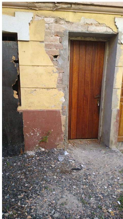
Foto 91: Porta colocada em vão do banheiro externo;
