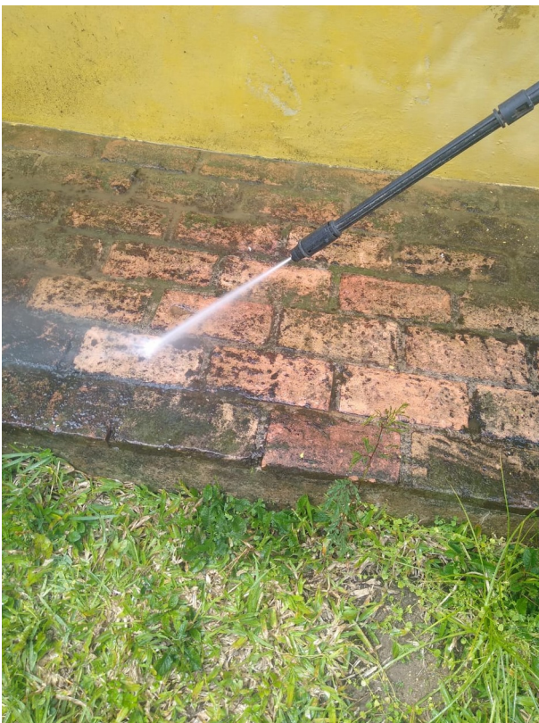
Foto 119: Limpeza das calçadas externas com hidrojateamento;
