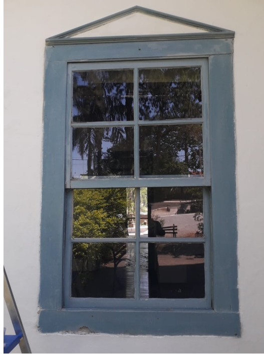
Foto 103: Retoques de pintura a cal e limpeza final ;
