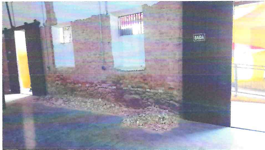
Foto 22: Retirada controlada de 60 % das argamassas soltas das paredes internas.
