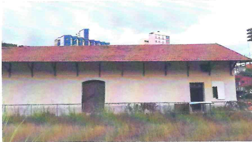
Foto 6: Outra vista do telhado concluído e 60% das argamassas da fachada posterior externa prontas.
