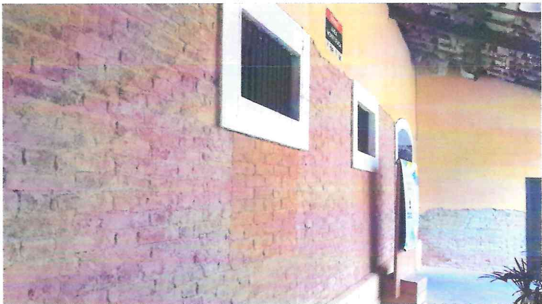
Foto 11: Retirada de 60 % das argamassas das fachadas externas .
