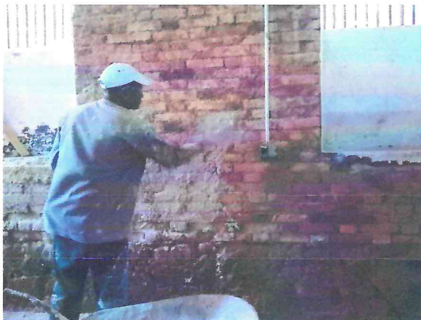
Foto 23: Chapisco das paredes internas com argamassa especial de areia e cal conforme especificações do projeto.
