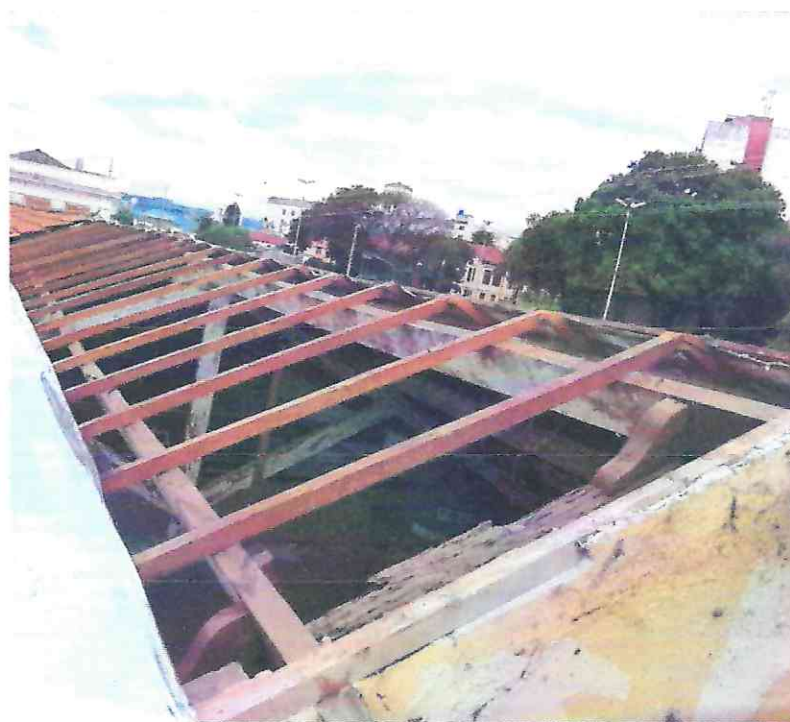
Foto 1:Retirada total de todas as telhas , ripas e mantas acústicas velhas .
