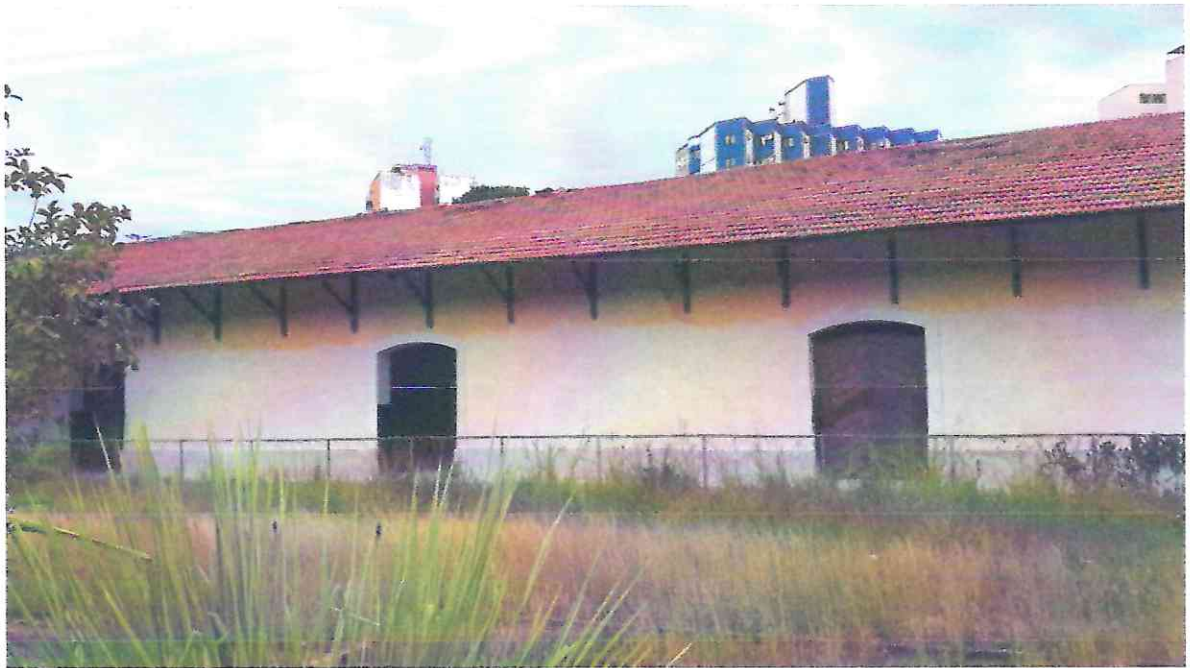
Fotos 30 e 31: Argamassas externas concluídas.
