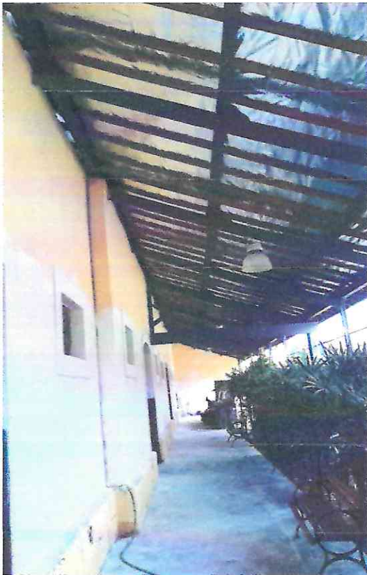
Foto 7: Detalhe da cobertura com manta aluminizada nova e 60% das argamassas da fachada frontal pronta.
