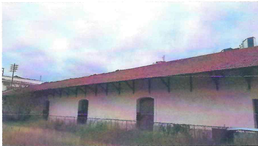
Foto 37: Detalhe das argamassas novas na fachada posterior, passando da altura das portas, bem acima da projeção da foto 36.
