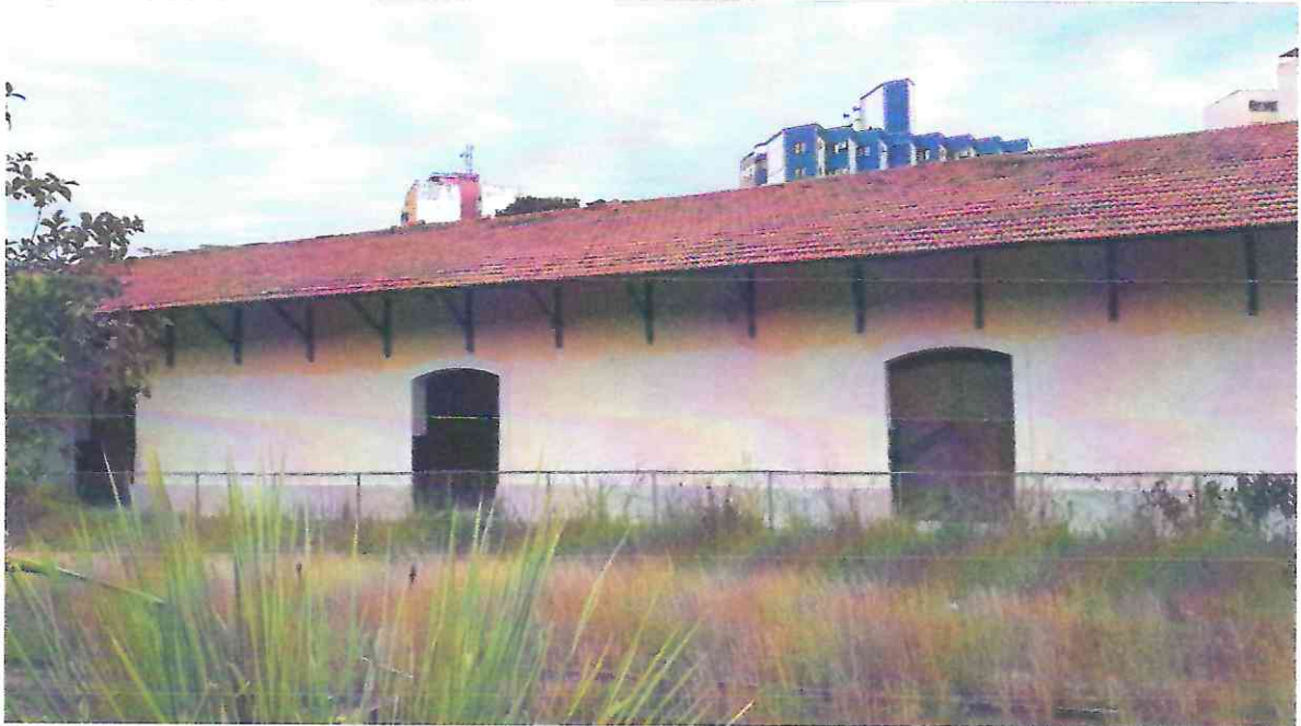
Fotos 30 e 31: Argamassas externas concluídas.
