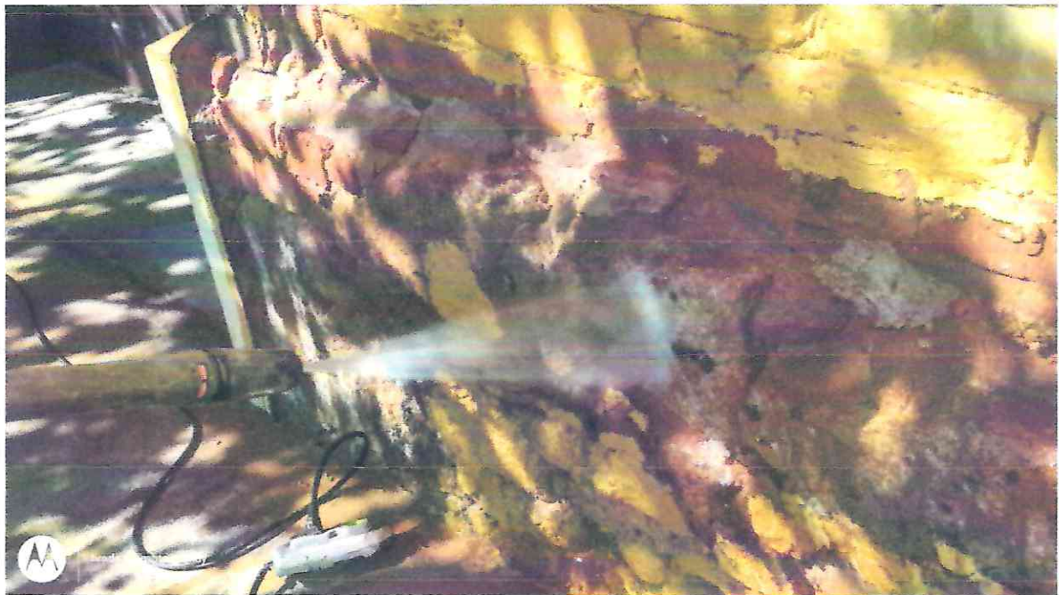
Foto 15: limpeza geral com hidrojateamento controlado.
