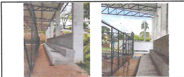
17.01.020 - ARGAMASSA DE REGULARIZAÇÃO E/OU PROTEÇÃO (piso de arquibancada)
