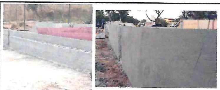
87894/87792 - CHAPISCO E EMBOÇO ALVENARIAS
