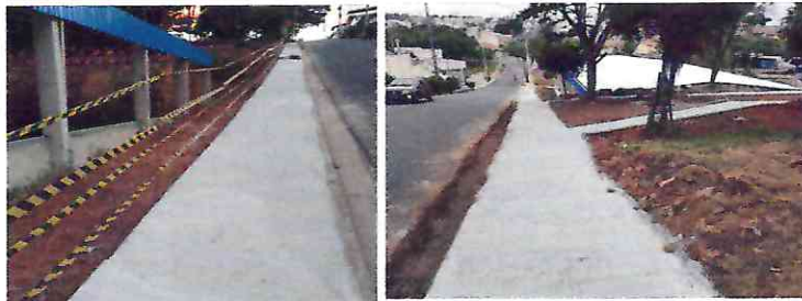
94992 - EXECUÇÃO DE PASSEIO (CALÇADA) OU PISO DE CONCRETO - PASSEIO PÚBLICO
