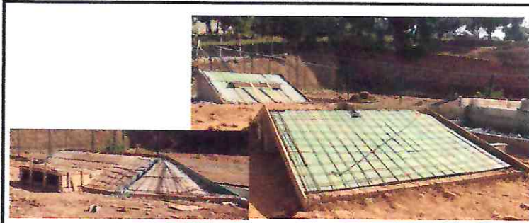
92776/92777/92778/92780 - ARMAÇÃO DA SUPERESTRUTURA - PISTA DE SKATE
