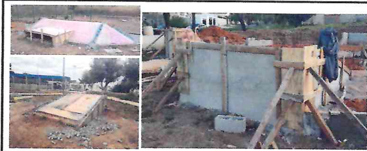
92270 - FABRICAÇÃO DE FÔRMA PARA VIGAS - PISTA DE SKATE
