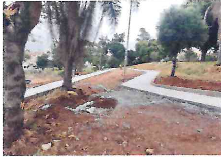
94992 - EXECUÇÃO DE PASSEIO (CALÇADA) OU PISO DE CONCRETO - PISTA DE CAMINHADA
