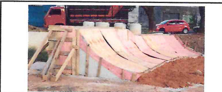
92270 - FABRICAÇÃO DE FÔRMA PARA VIGAS - PISTA DE SKATE
