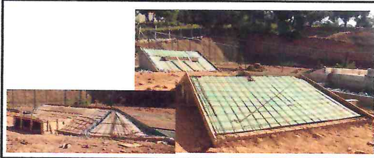
92776/92777/92778/92780 - ARMAÇÃO DA SUPERESTRUTURA - PISTA DE SKATE
