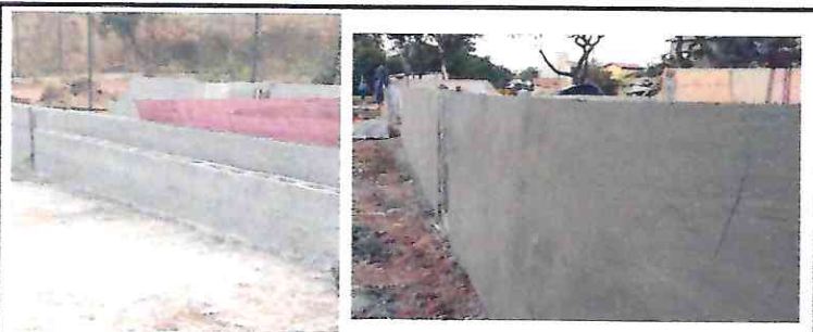
87894/87792 - CHAPISCO E EMBOÇO ALVENARIAS
