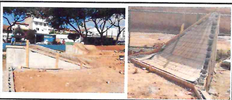
92776/92777/92778/92780 - ARMAÇÃO DA SUPERESTRUTURA - PISTA DE SKATE
