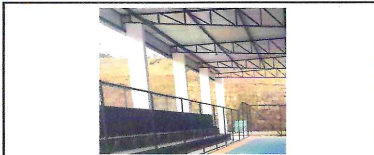
88495/88489 - APLICAÇÃO E LIXAMENTO DE MASSA LÁTEX EM PAREDES, UMA DEMÃO
