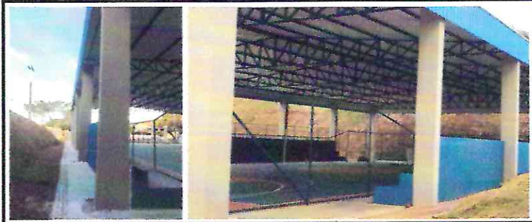
88489 - APLICAÇÃO MANUAL DE PINTURA COM TINTA LÁTEX ACRÍLICA EM PAREDES, DUAS DEMÃOS
