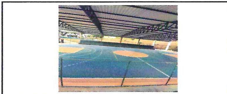
74245/001 /79467- PINTURA ACRILICA EM PISO CIMENTADO DUAS DEMAOS (área de jogo)/ PINTURA COM TINTA A BASE DE BORRACHA CLORADA, DE FAIXAS DE DEMARCAÇÃO, EM QUADRA
