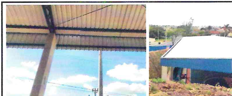
94228/94231 - CALHA EM CHAPA DE AÇO GALVANIZADO NUMERO 24, DESENVOLVIMENTO DE 50CM/ RUFO EM CHAPA DE AÇO GALVANIZADO NUMERO 24, DESENVOLVIMENTO DE 25CM
