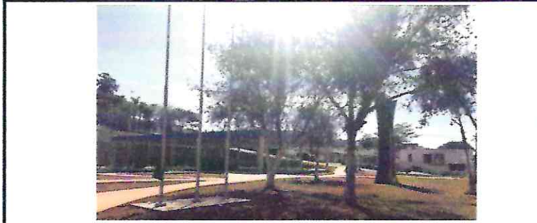
35.07.030 - PLATAFORMA COM 3 MASTROS GALVANIZADOS, H=9,00 M (Inclusos: base de concreto; 3 mastros em tubos de aço galvanizados, conj. de içamento e suspensão das
