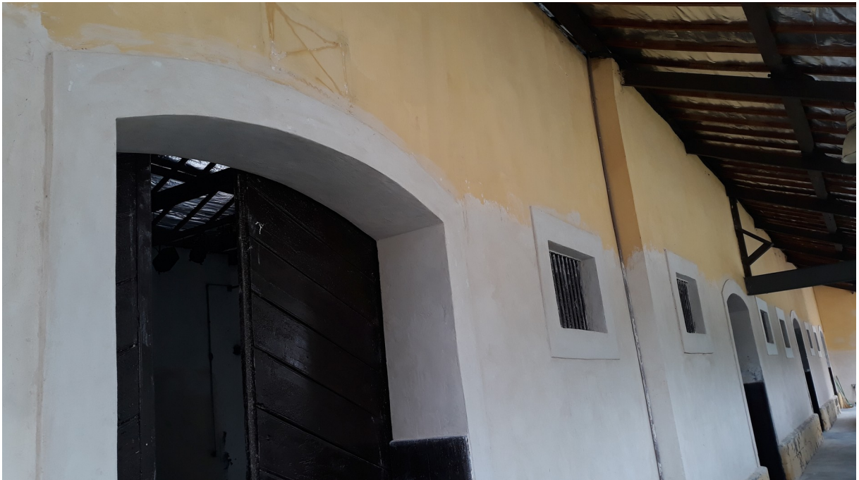
Foto 8: Detalhe da fachada frontal com 60 % de argamassa nova e requadramento das portas e janelas.
