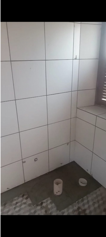
Foto 55: Outra vista da azulejaria com passagem de esgoto nova e recomposição do ladrilho hidráulico.
