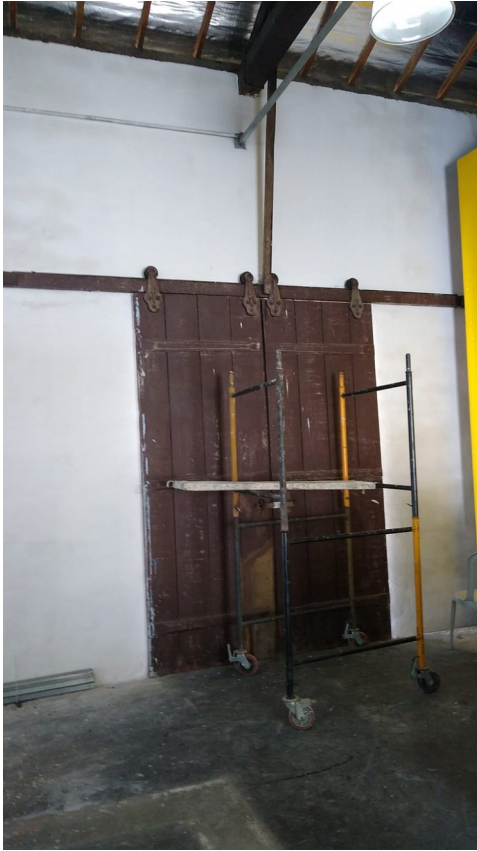
Foto 43: Detalhe da raspagem do verniz antigo das portas de madeira.
