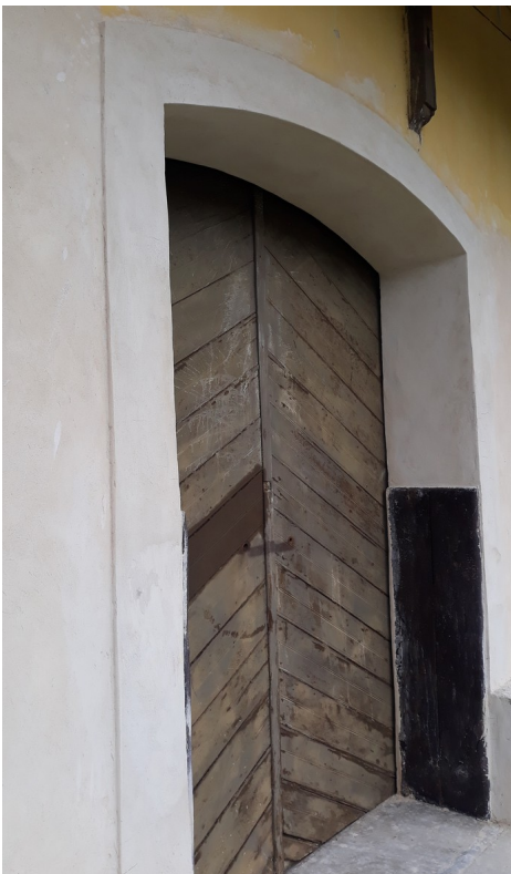
Foto 8: Detalhe da fachada frontal com 60 % de argamassa nova e requadramento das portas e janelas.
