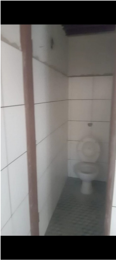
Foto 53: Azulejos velhos retirados e colocados azulejos novos.
