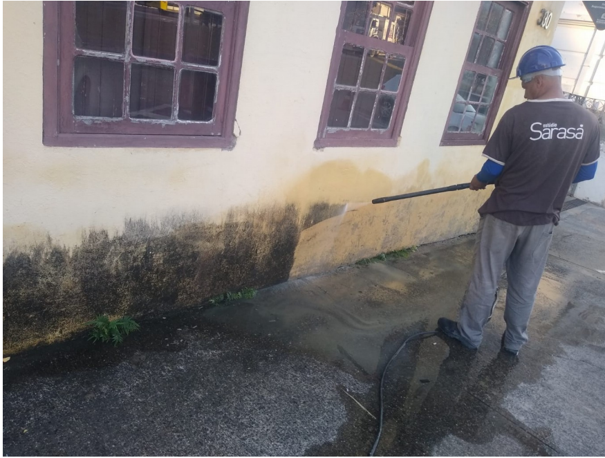
Foto 17: Limpeza geral das fachadas internas e externas.
