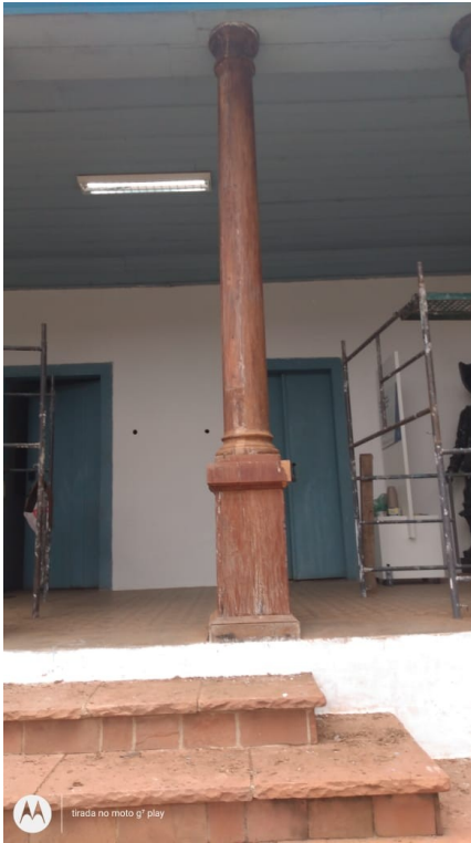
Foto 66: Lixamento do verniz velho das colunas de madeira da fachada principal.
