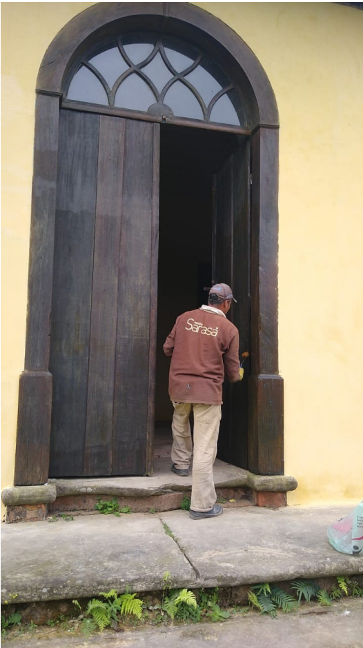
Foto 74: Lixamento e pintura com verniz stain nas portas e janelas de madeira.
