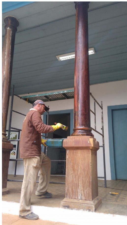
Foto 67: Pintura de verniz stain nas colunas de madeira .
