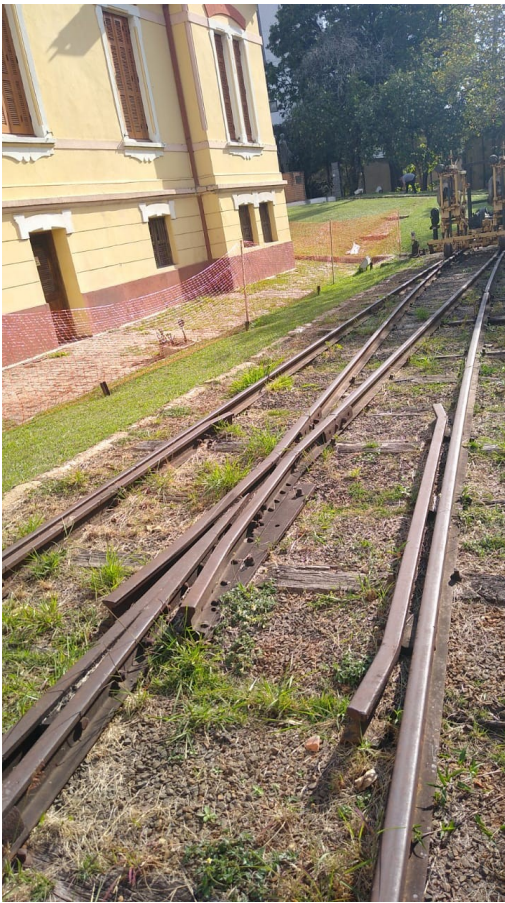
Foto 49: Detalhe de isolamento da obra tem tela de 1,20 m de altura
