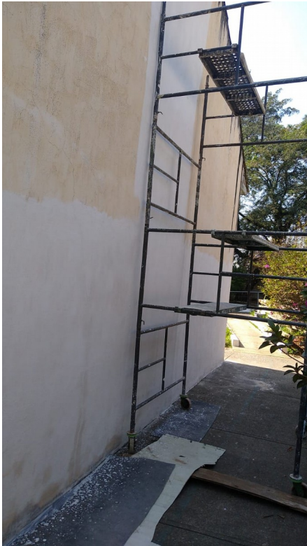
Foto 59: Detalhe de pintura a cal na fachada posterior com montagem de andaimes.
