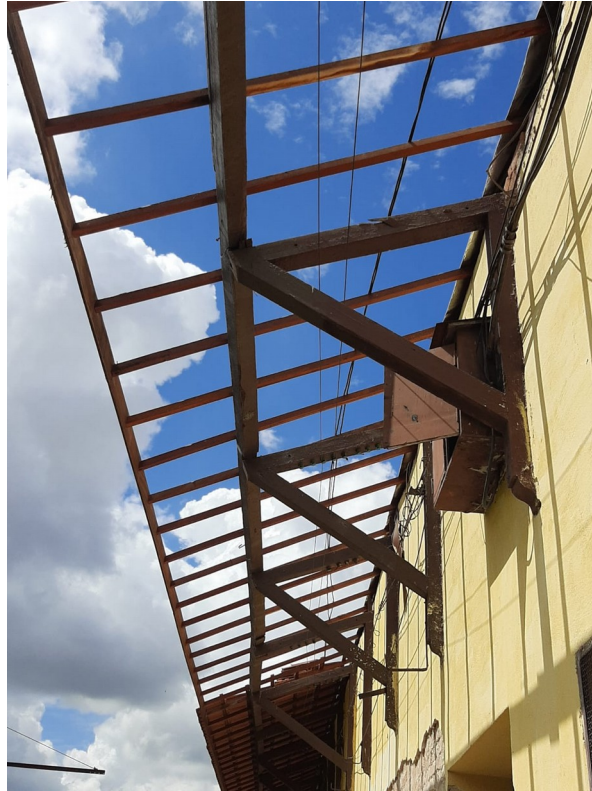
Foto 2: Retirada de telhas e ripas em sua totalidade na fachada posterior.
