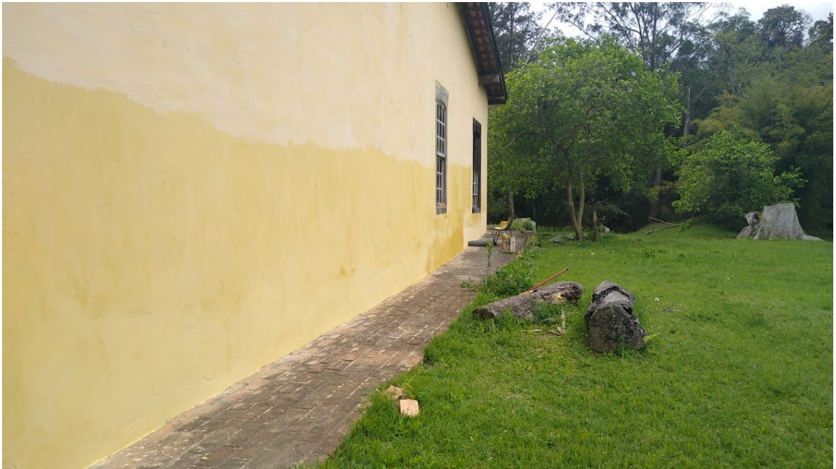
Foto 70: Detalhe de pintura a cal paredes externas.
