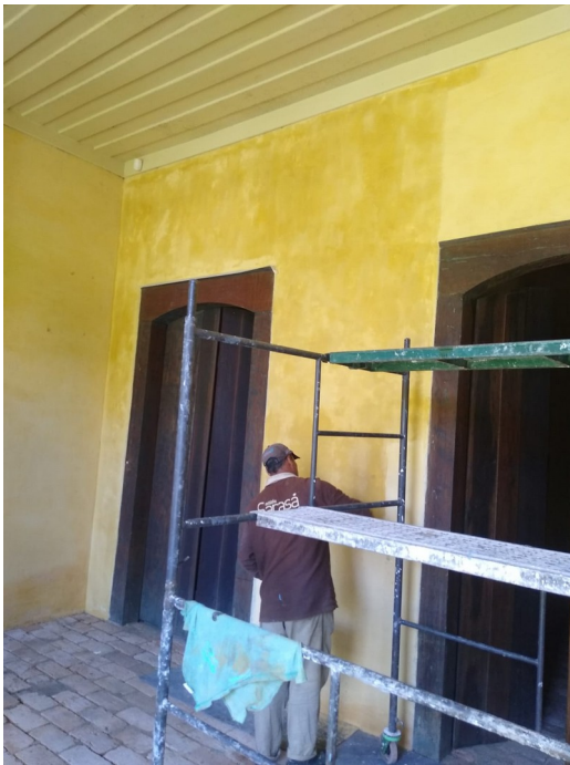
Foto 71: Pintura a cal das paredes internas.
