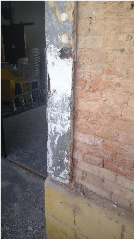
Foto 19 e 20 : Decapagem geral das molduras externas das portas e janelas para restauro.
