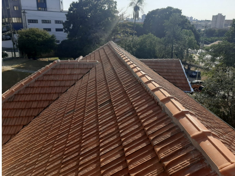
Foto 47: Outra vista do telhado novo.
