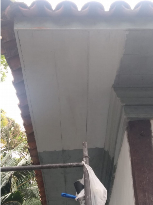
Foto 64: Lixamento e aplicação de fundo preparador de madeira nos beirais.
