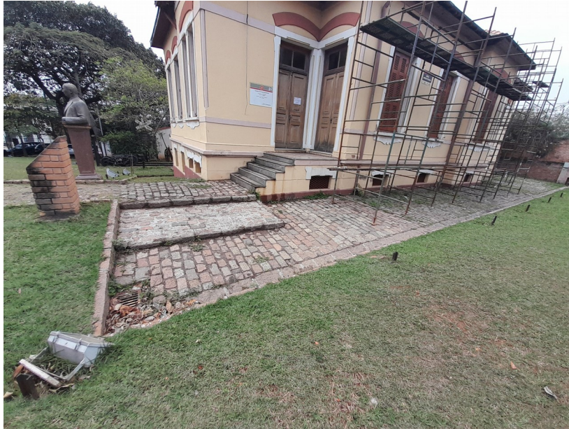
Foto 57: Detalhe dos andaimes na fachada lateral.
