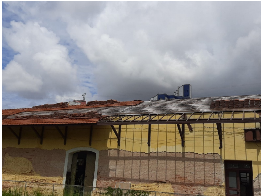
Foto 3: Colocação de manta acústica aluminizada dupla em toda área do telhado, menos do beiral da fachada posterior.
