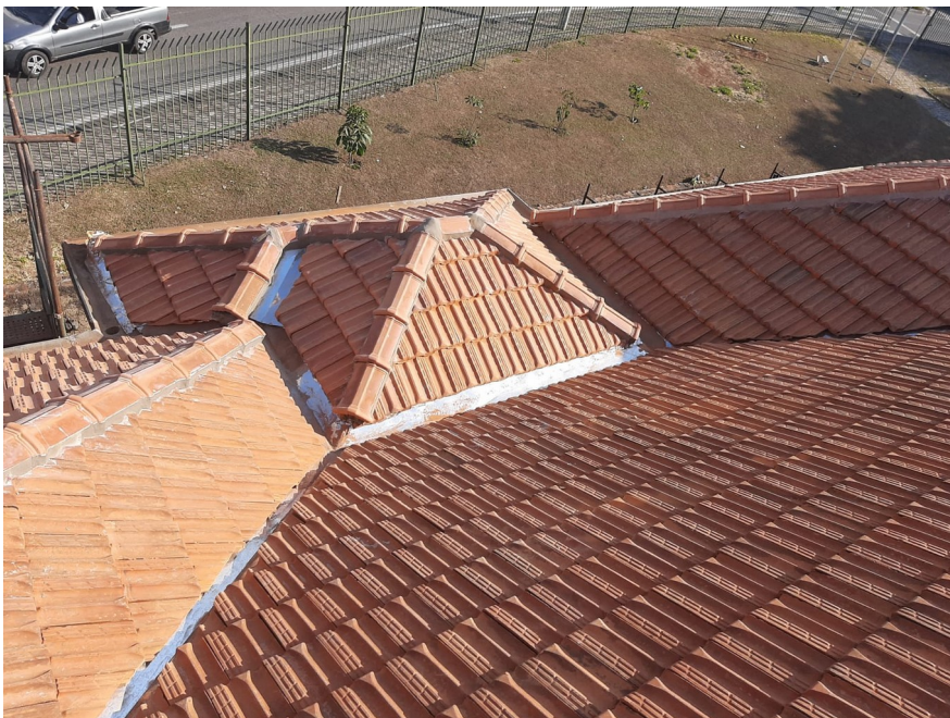
Foto 48: Outra vista telhado novo.
