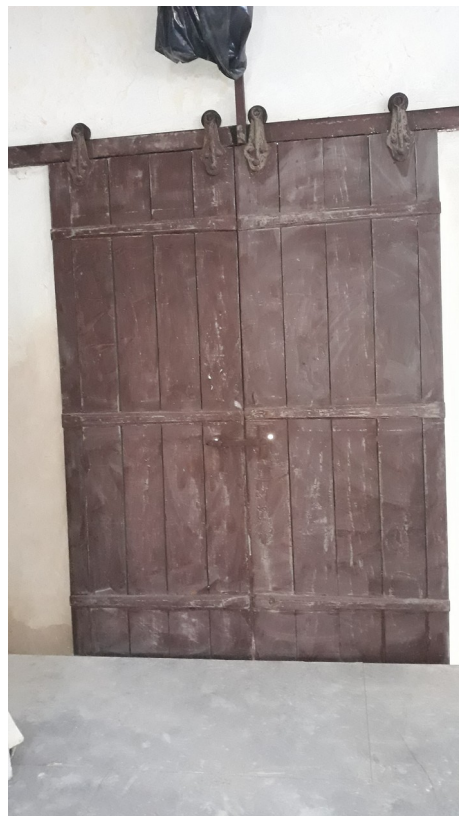
Foto 10: Portas lixadas para aplicação de stain conforme memorial descritivo.
