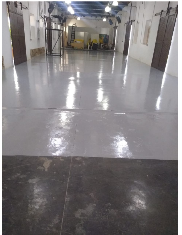
Foto 42: Pintura com tinta epóxi no salão interno.
