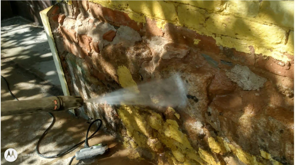
Foto 15: limpeza geral com hidrojateamento controlado.
