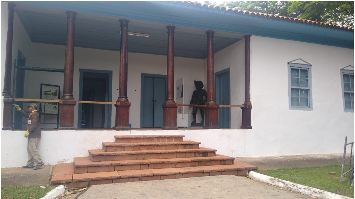
Foto 68: Vista da conclusão da pintura das colunas.
