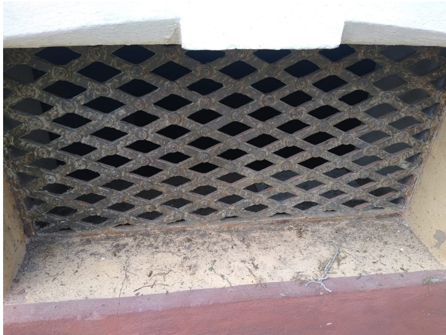
Foto 51: Gateiras metálicas lixadas.
