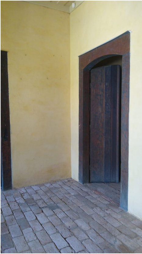
Foto 72: Pintura a cal concluída interna e externamente.
