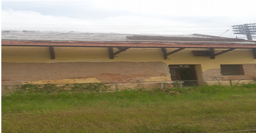
Foto 4: Colocação de manta aluminizada, ripas e telhas higienizadas, e detalhe da fachada posterior com 65% de retirada das argamassas soltas.
