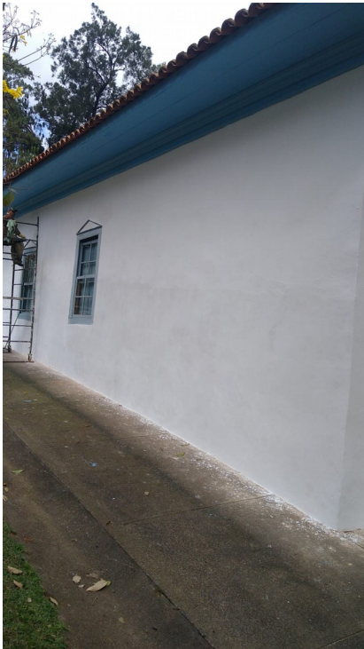
Foto 61: Pintura a cal fachada lateral.
