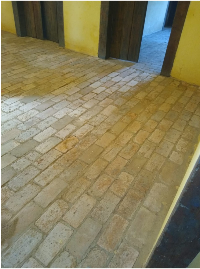
Foto 80: Detalhe de sala interna com piso tijolado higienizado, lixado e rejuntado.
