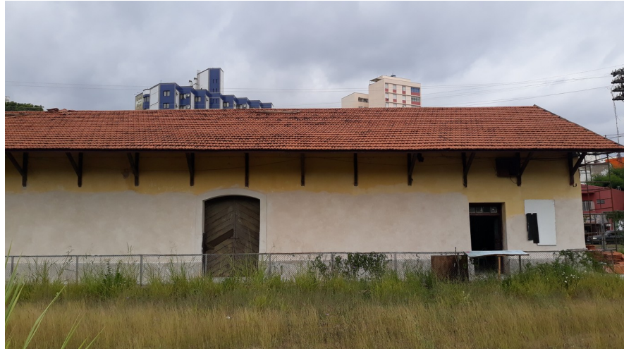
Foto 6: Outra vista do telhado concluído e 65% das argamassas da fachada posterior externa prontas.
