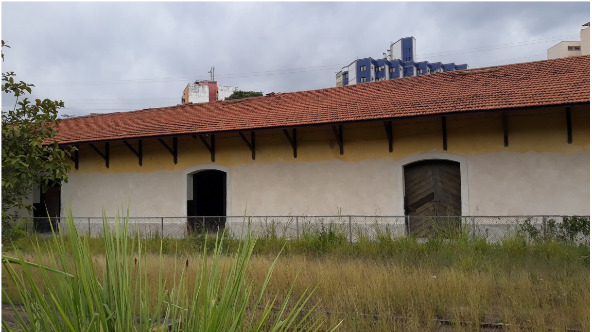
Fotos 30 e 31: Argamassas externas concluídas.
