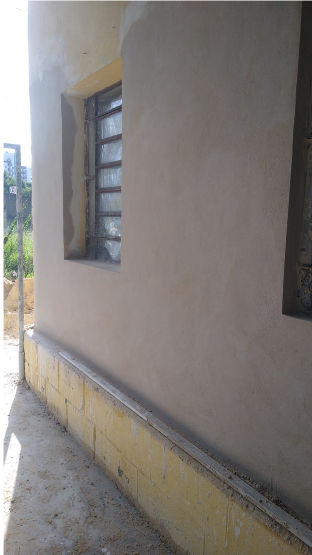
Foto 32: Detalhe da argamassa externa.
