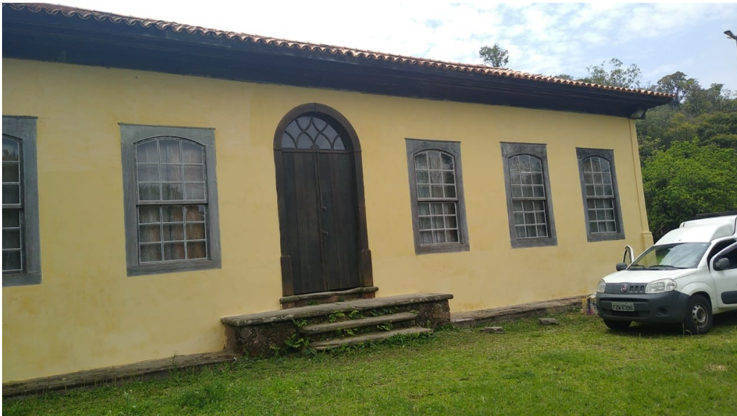
Foto 83: Fachadas externas finalizadas.
