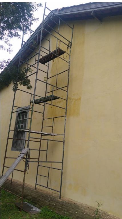
Foto 69: Detalhe da montagem de andaimes , limpeza e pintura a cal nas fachadas externas.
