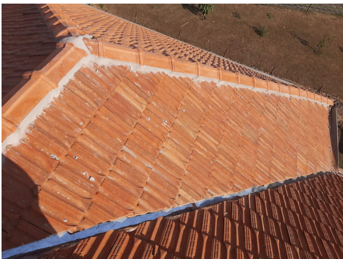
Foto 46: Detalhe do telhamento e colocação de calhas entre as águas.
