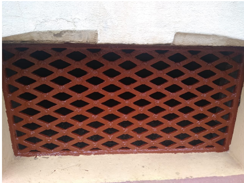
Foto 52: Gateiras metálicas pintadas com tinta esmalte.
