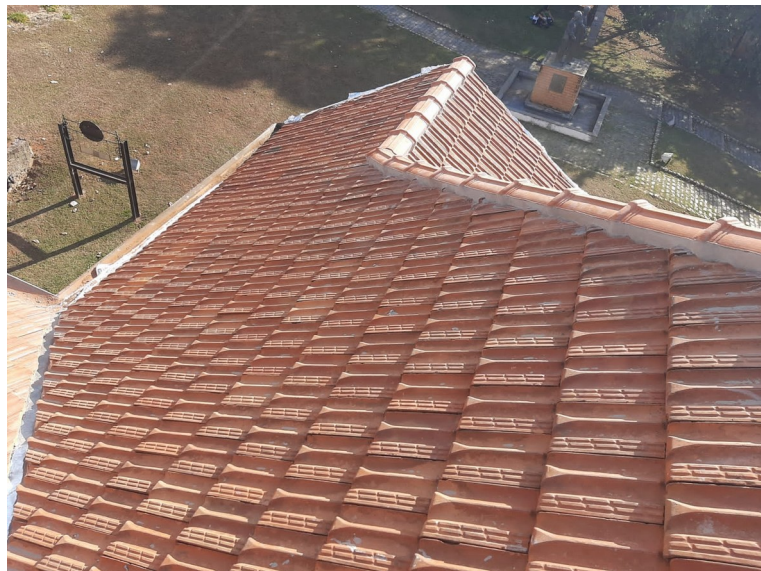
Foto 45: Detalhe do telhado com cumeeiras chumbadas.
