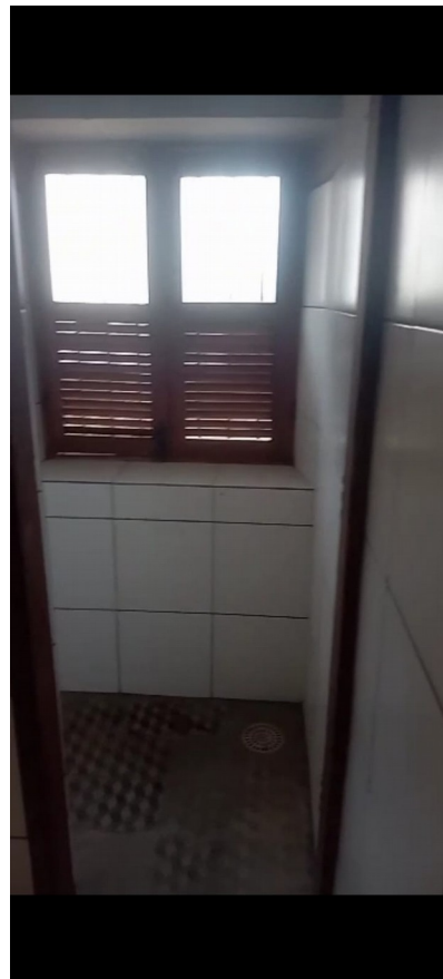
Foto 54: Outra vista da azulejaria nova do banheiro.
