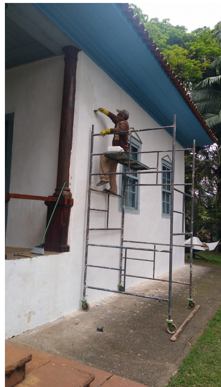
Foto 60: Pintura a cal cachada principal.
