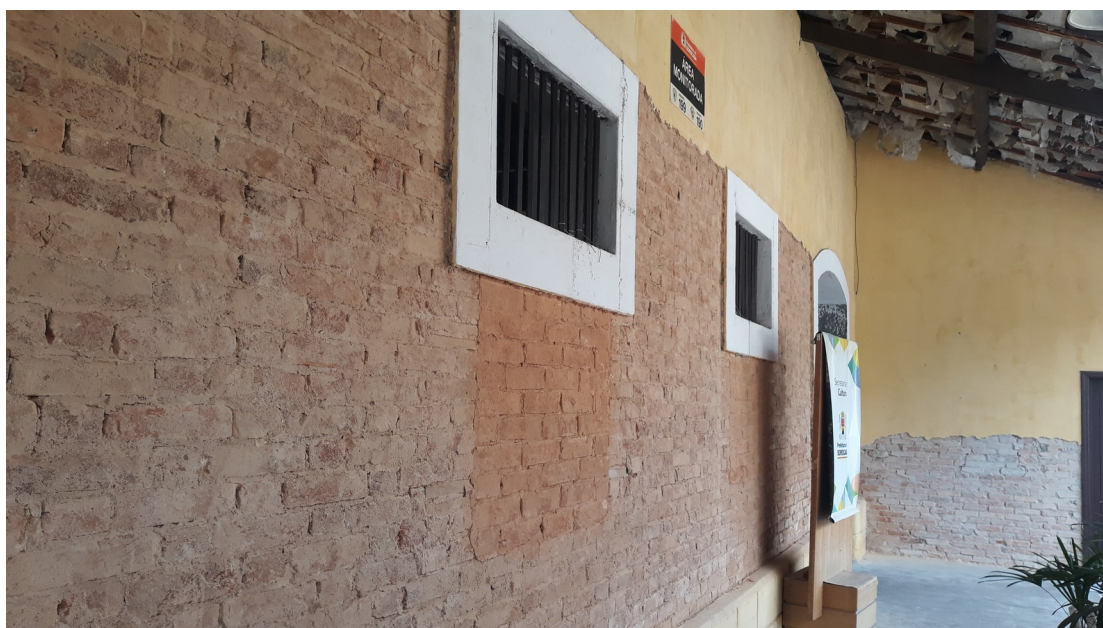
Foto 11: Retirada de 60 % das argamassas das fachadas externas .
