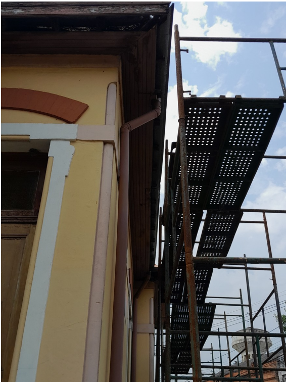
Foto 58: Detalhe dos andaimes.
