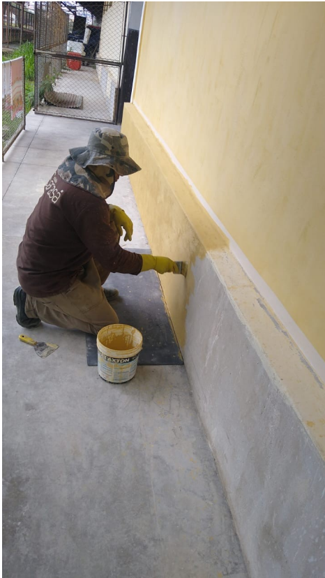
Foto 39: Detalhe da pintura do barrado da fachada posterior.
